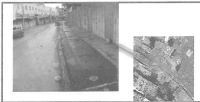
الصورة ٨: توضح تكسر الأرصفة واهترائها....(منطقة باب الزاوية)..... "٢٠١١ / ٢ / ٢٤..تامر الهيموني"
